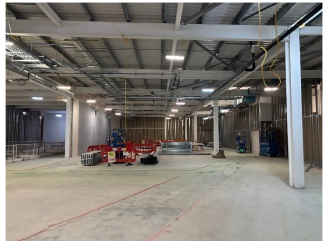
Leinin sych a gwaith mecanyddol a thrydanol yn y Parth Adloniant
